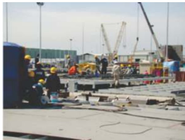
Công nhân PVSb thi công chế tạo và lắp đặt các công trình cơ khí dầu khí đảm bảo an toàn
