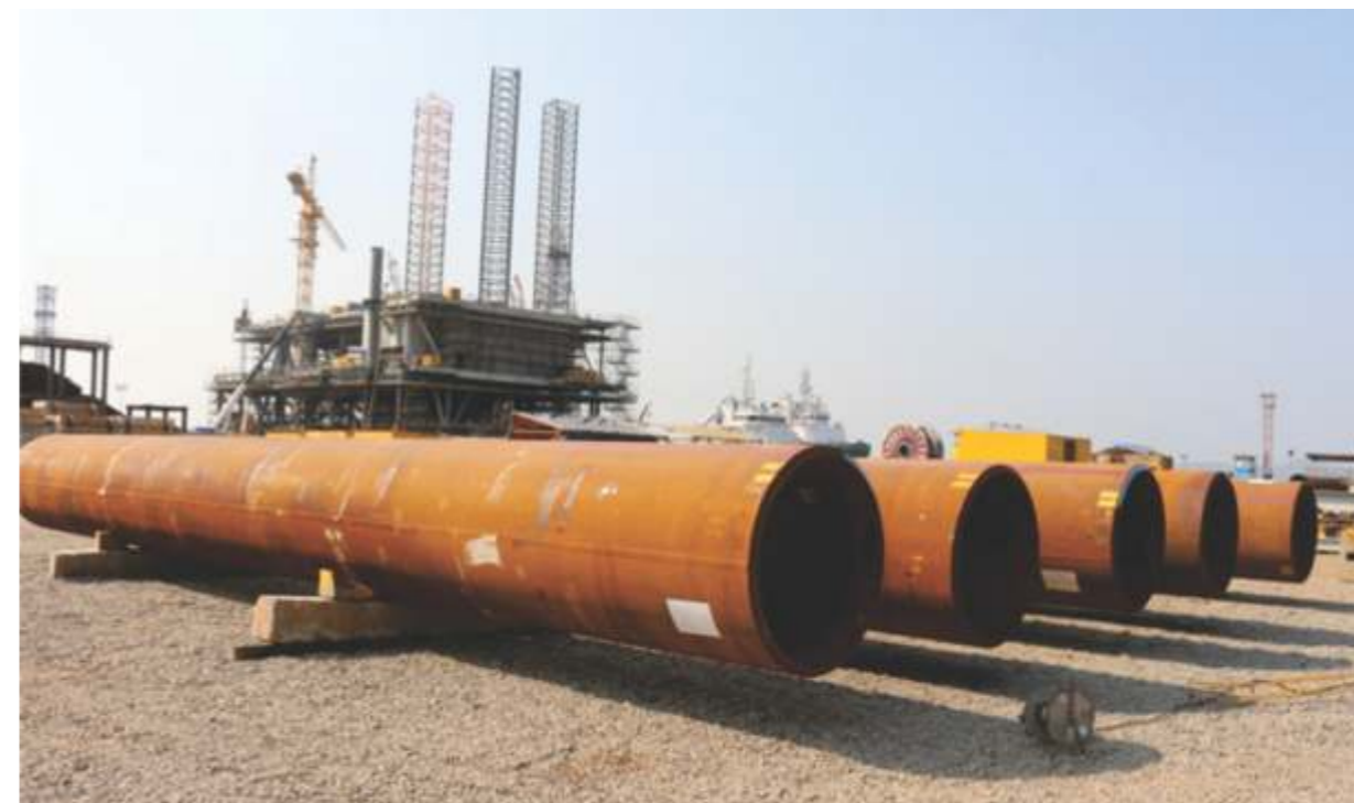
Thi công thực hiện hợp đồng cung cấp dịch vụ chế tạo SVSW Piles and Conductor Piles cho PTSC M&C thuộc Dự án Sư Tử Vàng Tây Nam
